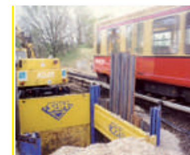
Instalacja szalunku w obudowie słupowo-płytowej z rozporą rolkową, w zewnętrznej prowadnicy
