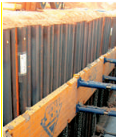
Płyty komory dylowej h = 1,00m
