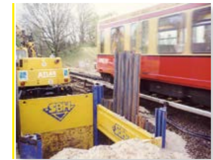
Структура на бокс с подвижна подпора с използване на листови пилоти
